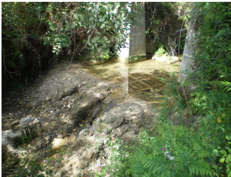
Fotografía 4.1. Toma de agua para recarga artificial en el arroyo de Camoján
