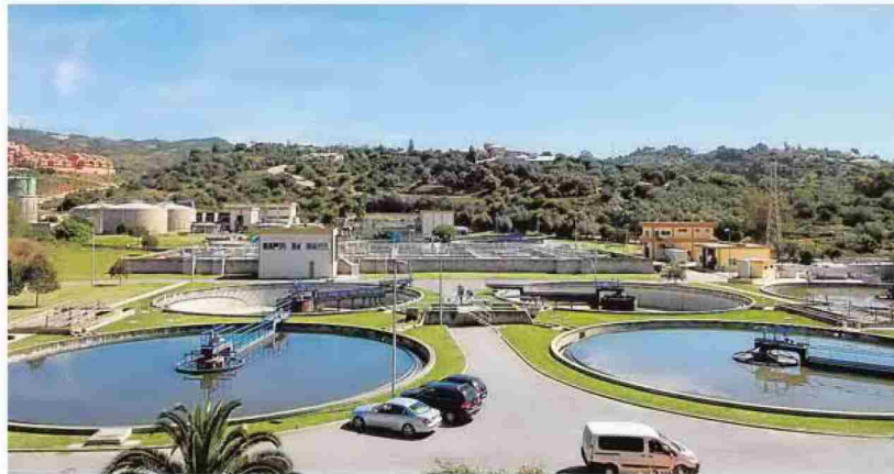
La investigación se desarrollará en la depuradora de aguas residuales de La Víbora (Marbella). sur
