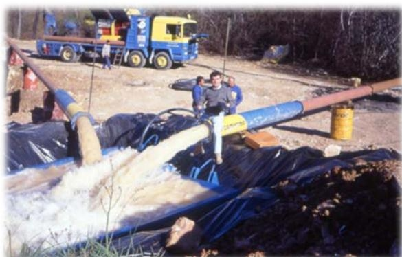
Foto 5: Prueba de bombeo en el sondeo S-41, perforado en el entorno del manantial de Cañamero con motivo de la Metasequía de 1995.
