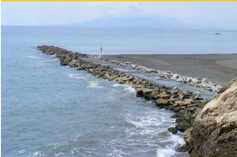
En primer plano, se observa la playa de La Cala del Moral, protegida mediante un espigón. Los espigones, una de las formas de protección de la costa más extendidas en todo el mundo, están diseñados para resguardar una playa natural existente o bien para generar artificialmente una playa. El efecto que persigue el espigón es la difracción del oleaje, de forma que se reduzca el ángulo de aproximación
